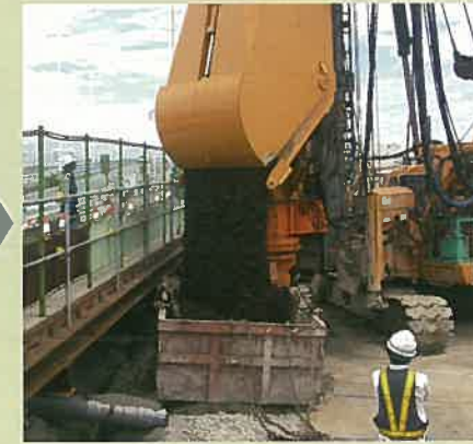
排土ホッパーからの土の搬出
