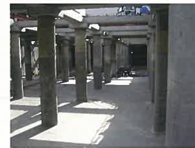
⑤底板コンクリート打設
