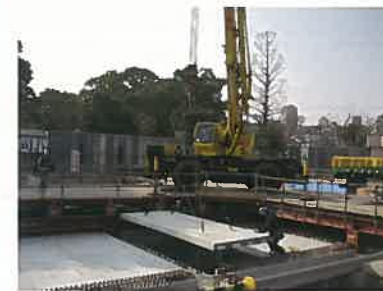
⑥プレキャストスラブ材の布設
