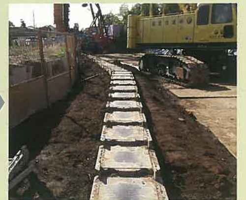
PC-壁体の沈設完了
