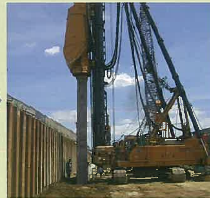
下部材の沈設
