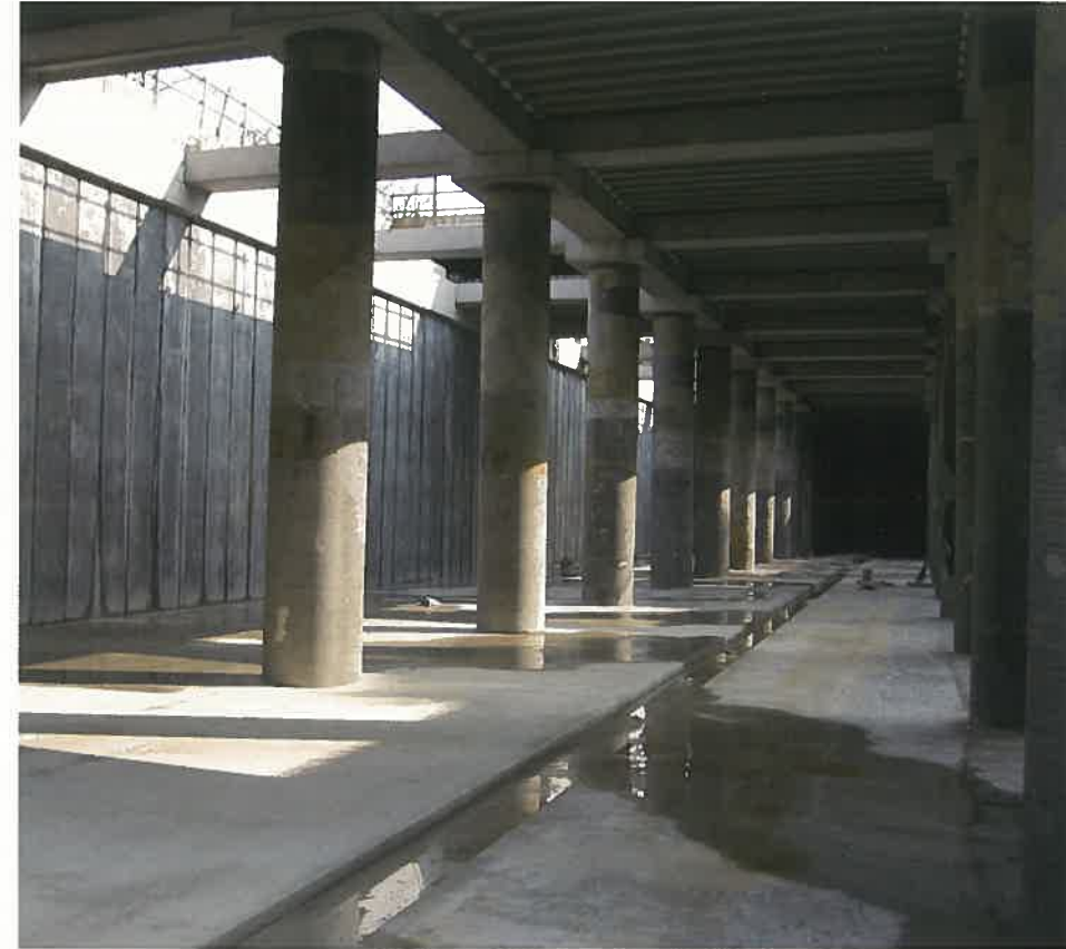
①PC-壁体・中柱の施工
