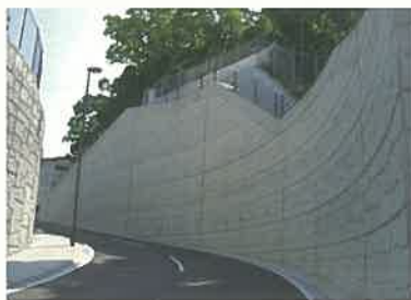
コンクリート打設仕上
