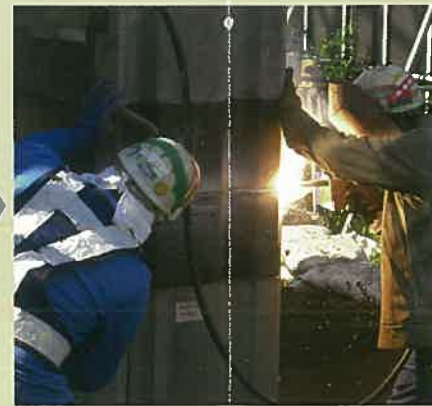
上部材の建込み・継手溶接
