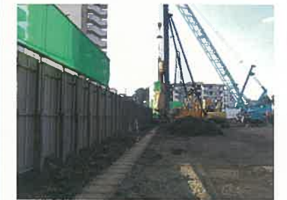
①PC-壁体・中柱の施工
