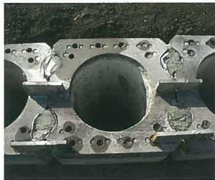
モルタル充填完了
