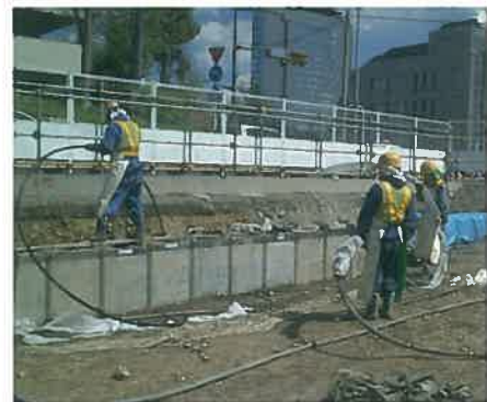
モルタル注入
