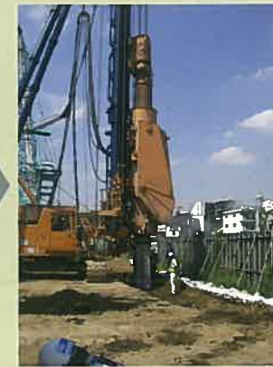
上部材の沈設
