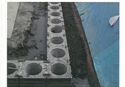
②PC-壁体施工完了
