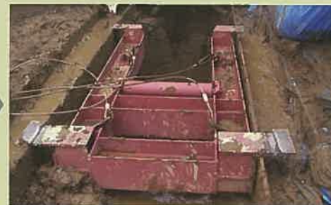
PC-壁体建削孔用定規の設置
