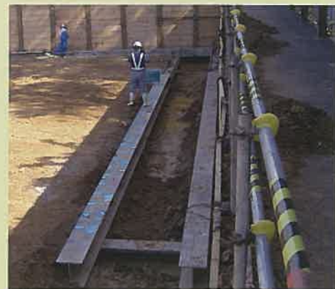
削孔用定規の設置
