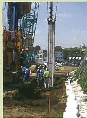
下部材の建込み
