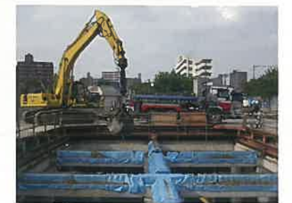
④内部掘削
