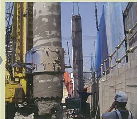
補助クレーンによるPC-壁体の沈設
