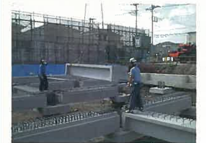
③プレキャスト梁部材の設置
