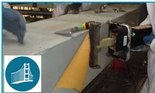
橋桁：防錆コーティング
