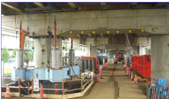
— 道路橋耐震補強の施工状況 —
