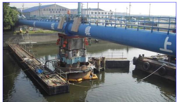
— 水管橋耐震補強の施工状況 —
