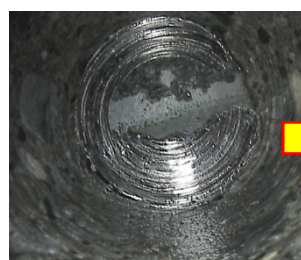
開削前（孔内処理後）
