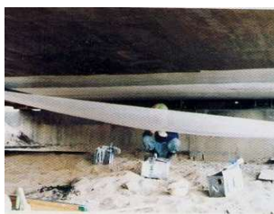
4. 補強シート (NSVシート貼り付け)
