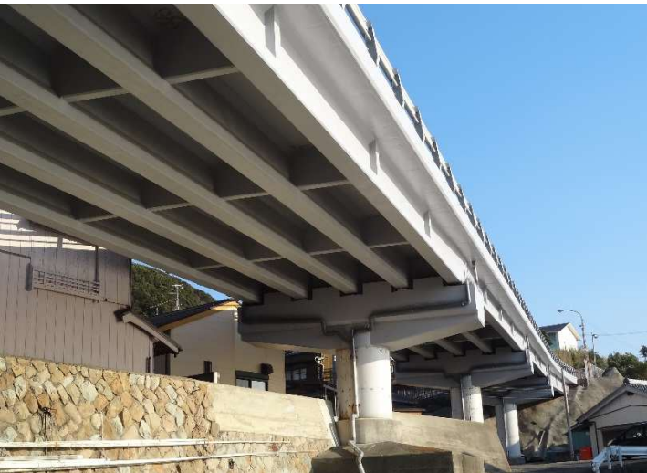
見老津高架橋(和歌山県)，PC橋
