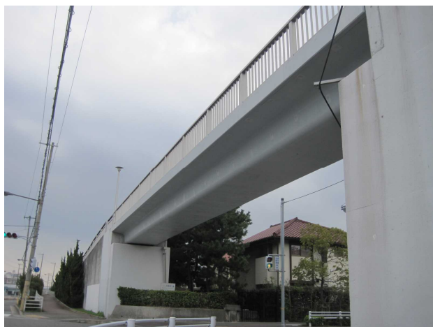
打出浜歩道橋(兵庫県)
