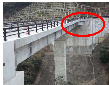
ポストテンションPC桁(枝桁)
