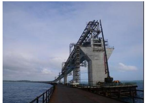
伊良部大橋 P27~P32径間 PC箱桁 セグメント製作・架設295m
