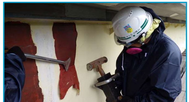
IH 式 RPR 装置による被膜除去の状況
