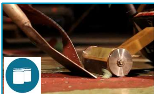
タンク：ガラスフレークライニング
