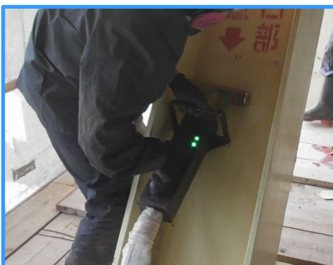
施工事例：トラス
