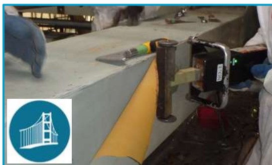
橋桁：防錆コーティング
