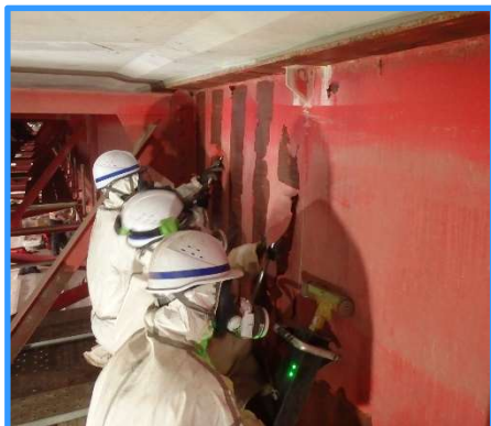
施工事例：鋼桁
