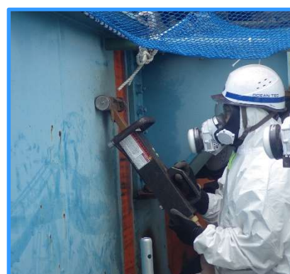
施工事例：鋼支柱
