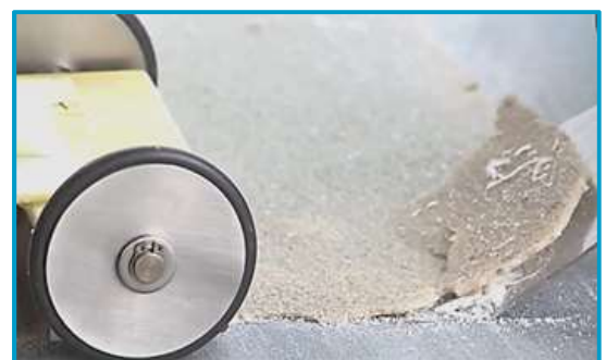
剥離した被膜はスクレイパー等で容易に除去
