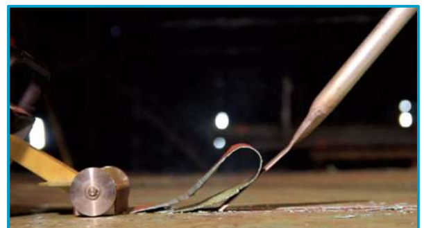
タンク内のガラスフレイクライニング除去の状況
