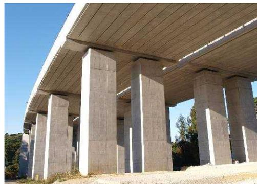
SCBR工法により架替えを行ったプレテンション方式PC連続桁橋
