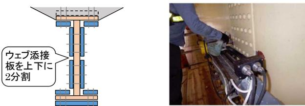
**手順2** 下フランジ連結部にバイパス材を取付けます。
