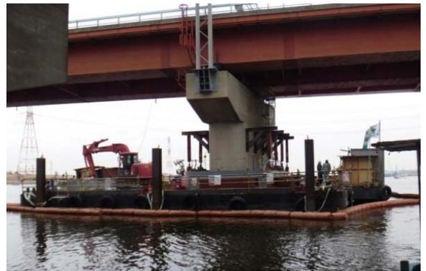
◎ 締切設置地盤が軟弱である。(鋼矢板の根入れ長が長くなる。)
