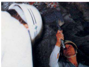
前処理 下地調整 (セルタルペーストP塗布)
