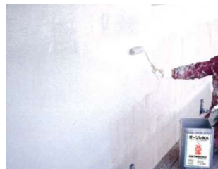
3. 中塗り・補強シート (オーソLNA・NSVシート)
