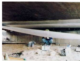
4. 補強シート (NSVシート貼り付け)
