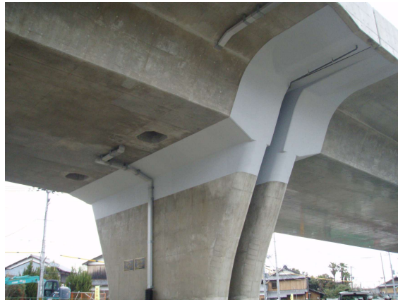
京都第二環状道路 長岡高架橋(京都府)
