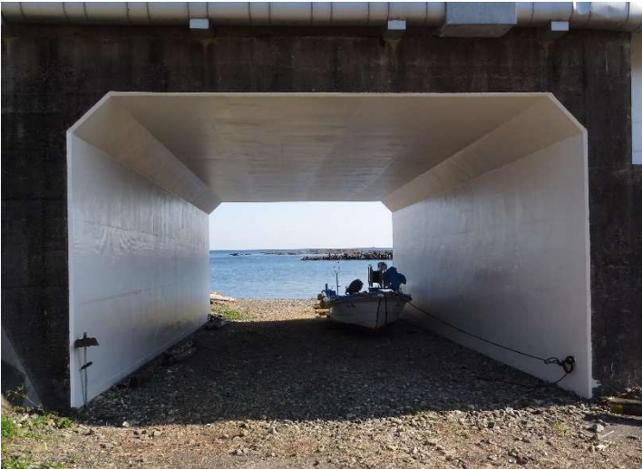
津苅橋(和歌山県) , ボックスカルバート
