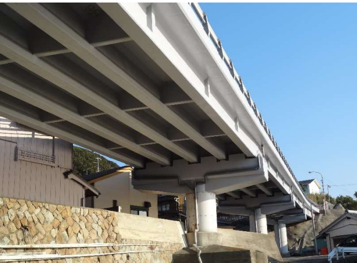
見老津高架橋(和歌山県) , PC橋
