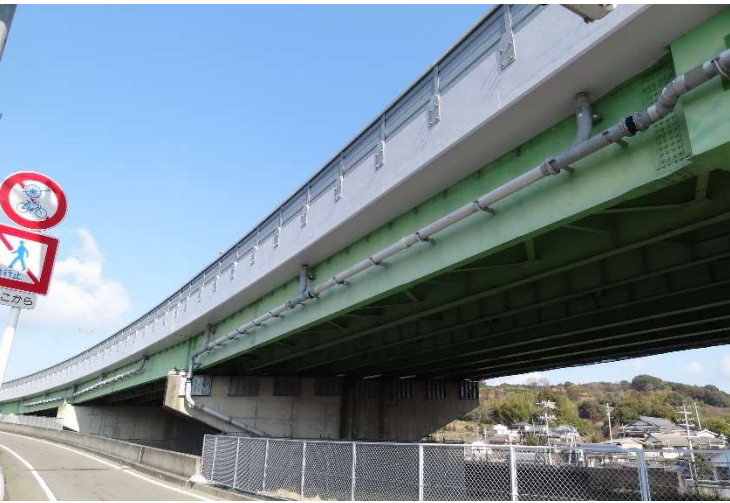
秋津高架橋(和歌山県)，鋼桁橋・壁高欄
