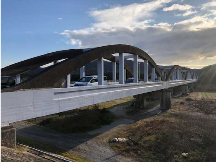
大原橋(岡山市)，RC橋
