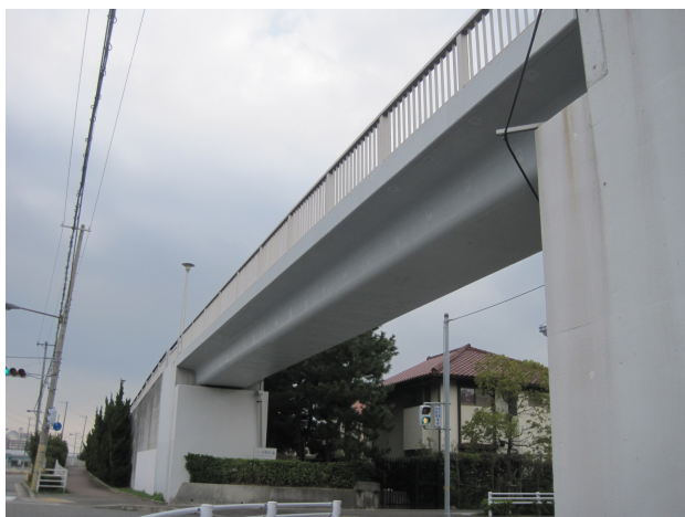
打出浜歩道橋(兵庫県)
