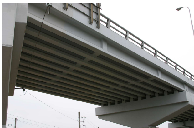
横武跨線橋(佐賀県)
