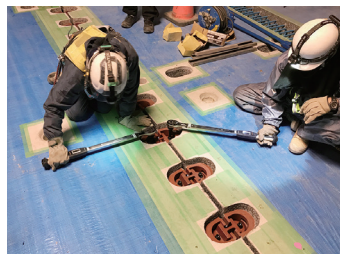
③ H型金物挿入、ボルト締付け
