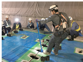
② 床版設置(専用治具を使用)
