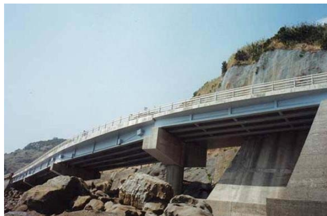
施工事例(PC橋)
