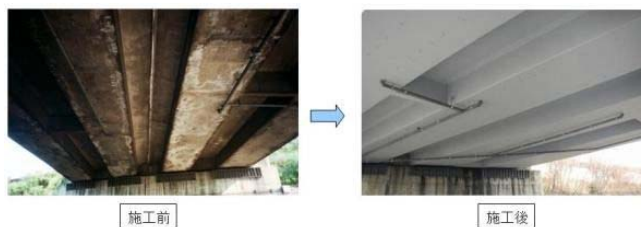
施工事例(RC橋)
