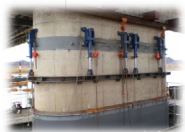
ピア-リフレ工法
