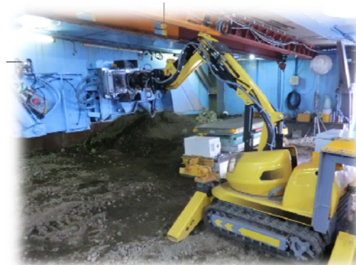
掘削機械の組立・解体用の機械・遠隔動作試験
