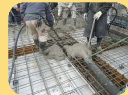
③ コンクリート打設
