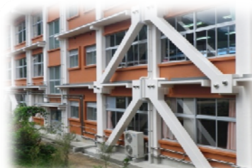
小学校校舎 (PCa プレース工法)
