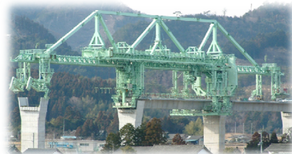
橋梁架設機材の管理・改造
