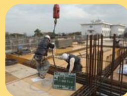
② PC 鋼材配線
