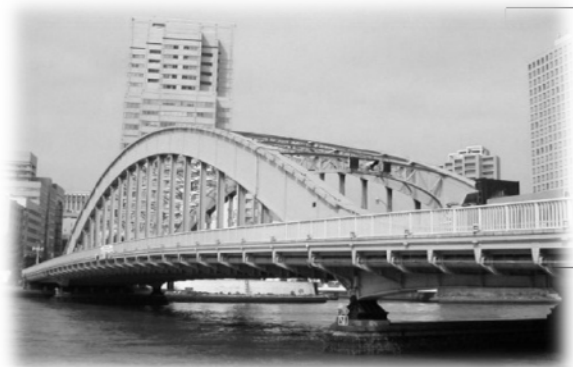
永代橋基礎(隅田川)
