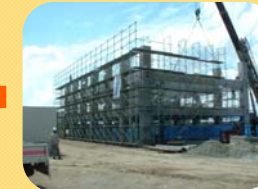
③ PCa 部材架設
