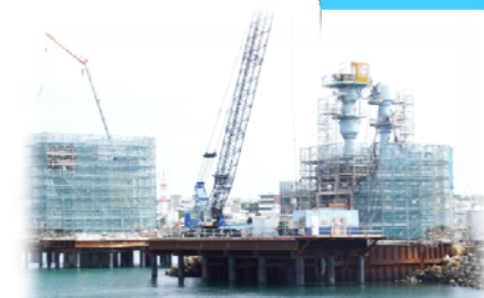
沖縄県牧港高架橋橋脚基礎
