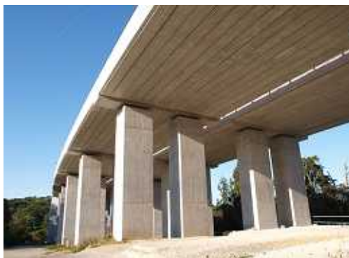
プレテンション方式3+6径間連続PC中空床版橋 塩害およびアルカリ骨材抑制対策
