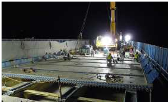
伊芸高架橋：沖縄県
