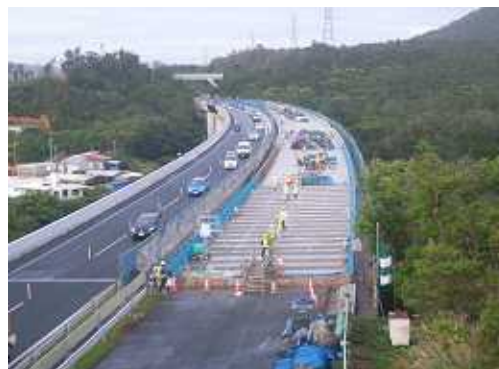
橋長387m 床版取替え工事 塩害抑制対策
