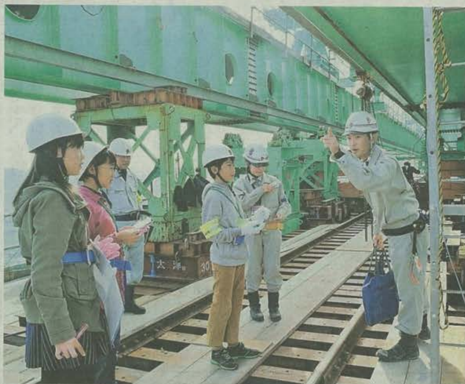
建設中の住吉橋の上で担当者に橋造りの説明をもらった
